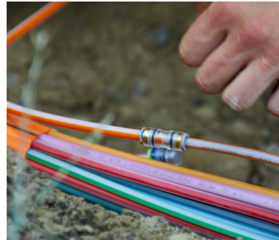
Glasfaser-Kabel zum Haus
