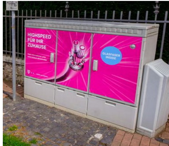
Netzverteiler (NVt)
