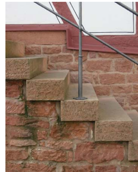
Treppenanlage in Sandstein
