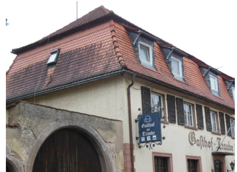
Mansarddach mit Tonbiber
